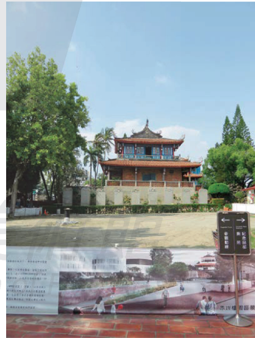
圖3 2021年，園區進行整修中的赤崁樓。連子儀攝。
