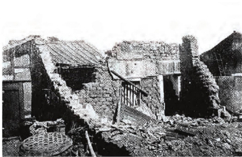
圖8 佐野利器，〈嘉義廳新港街的土塙厝潰倒〉，1905，圖片來源：中央氣象局主編，《臺灣十大災害地震圖集》（臺北：中央氣象局，1999），頁14。
