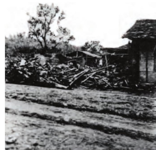
圖11 臺灣總督府氣象臺，〈臺南新營郡白河庄的土塙厝潰倒〉，1942，圖片來源：中央氣象局主編，《臺灣十大災害地震圖集》（臺北：中央氣象局，1999），頁146。
