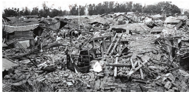
圖10 臺灣新聞社，〈新竹州苗栗郡公館庄的土塙厝潰倒〉，1935，圖片來源：中央氣象局主編，《臺灣十大災害地震圖集》（臺北：中央氣象局，1999），頁108。
