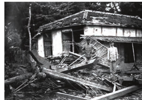
圖2 臺北測候所，〈南投廳林圯埔支廳的建築全倒塌情形〉，1916，圖片來源：中央氣象局主編，《臺灣十大災害地震圖集》（臺北：中央氣象局，1999），頁74。
