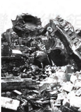
圖24 臺灣總督府氣象臺，〈獅頭山獅巖洞與金鋼寺被震壞的樣貌〉，1936，圖片來源：中央氣象局主編，《臺灣十大災害地震圖集》（臺北：中央氣象局，1999），頁104。
