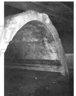
圖17 明治39年（1906）埋設於原清代臺北府城地下之馬蹄型排水管，圖片來源：李乾朗，《臺北府城牆及礮臺基座遺址研究》，頁31。
