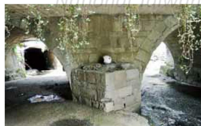
圖28 東寧橋橋墩可見石材砌築方法，圖片來源：吳瑞真提供（2017.3.18拍攝）。
