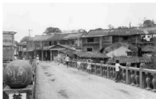
圖24 呈甘橋原貌。橋墩為石材砌築，護欄做酒瓶狀欄杆，橋面以泥土夯實，供人車通行，圖片來源：黃承令計劃主持，《新竹縣定古蹟關西東安橋及歷史建築芎林呈甘橋修復再利用計畫》，頁6-12。
