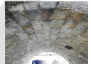
圖14 東寧橋石砌情形，圖片來源：吳瑞真提供（2017.3.18拍攝）。
