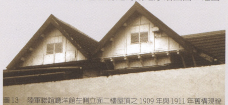
圖13 陸軍聯誼廳洋館左側立面二樓屋頂之1909年與1911年舊構現貌
