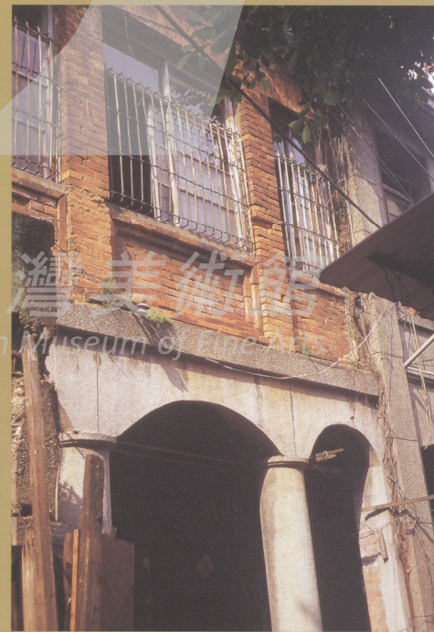
剝皮寮老街(康定路173巷1號)中的三拱牌樓面店屋，一樓為洗石子飾面，二樓為磚構材。
