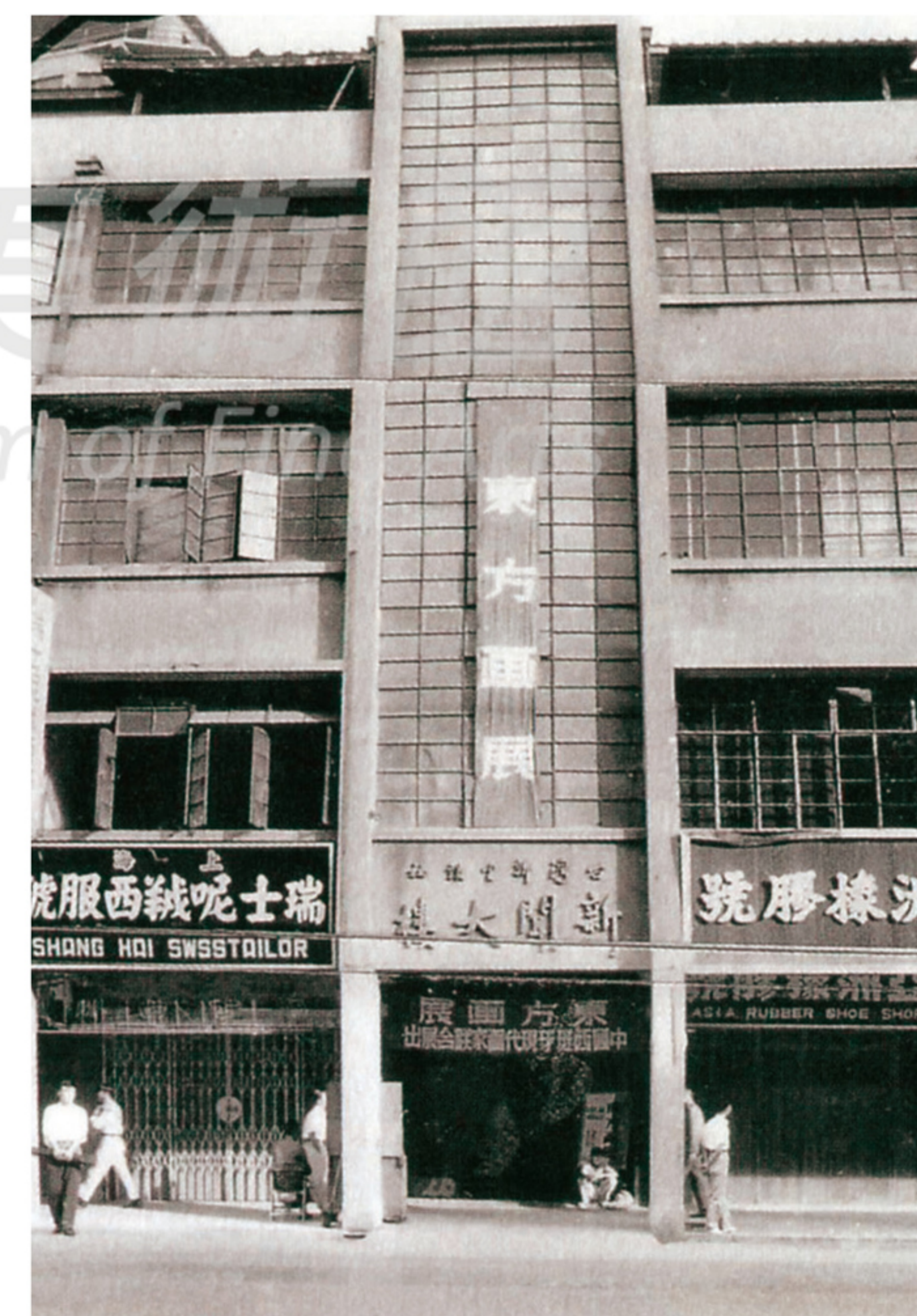
1957年「東方畫展」於臺北新聞大樓舉行，圖中央的建物即為大樓外觀。
