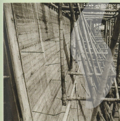
鋼骨水泥屋面已完成，顯示外部鷹架與屋面分離。(1963/8/20)
