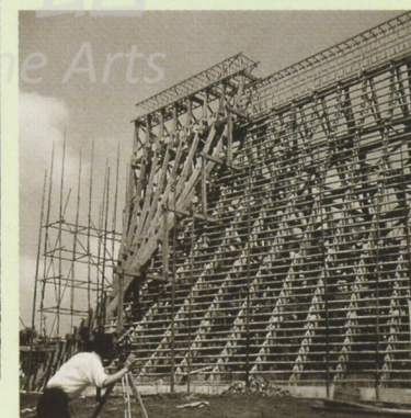
在外部模板支撐上放橫樑。 (1963/4/15)
