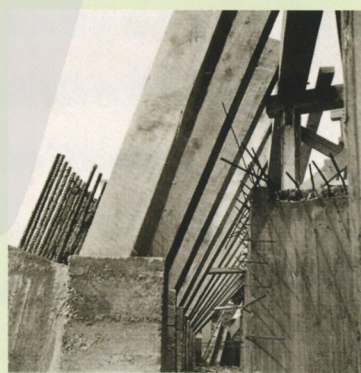
模板支撐，每根角度不同。 (1963/3/20)
