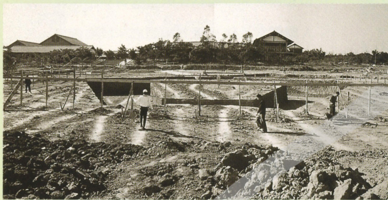
教堂初步挖出六角形地基。(1962/11/1 ~ 1963/1/30)
