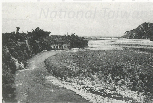
2-1 葫蘆墩圳水門
